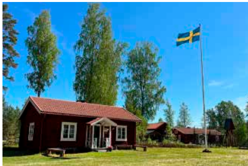
Den nyrenoverade Almastugan
