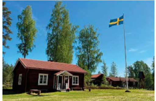
Den nyrenoverade Almastugan
